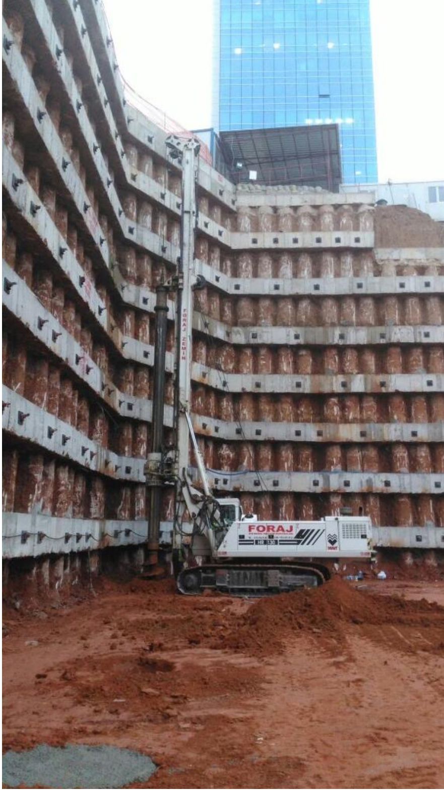
Zemin ankrajlı iksa sistemi
