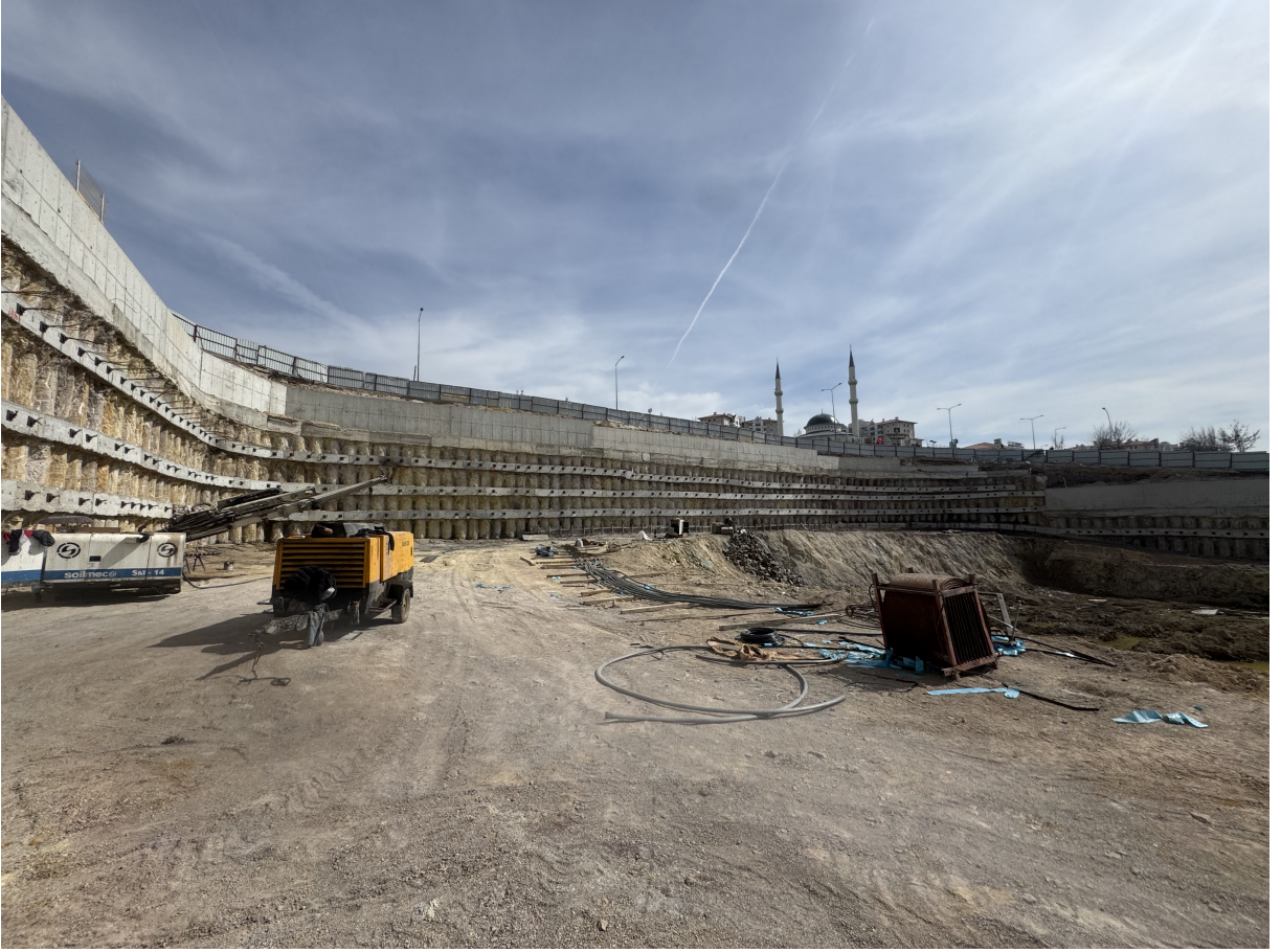
Geçici zemin ankrajı ve fore kazık
