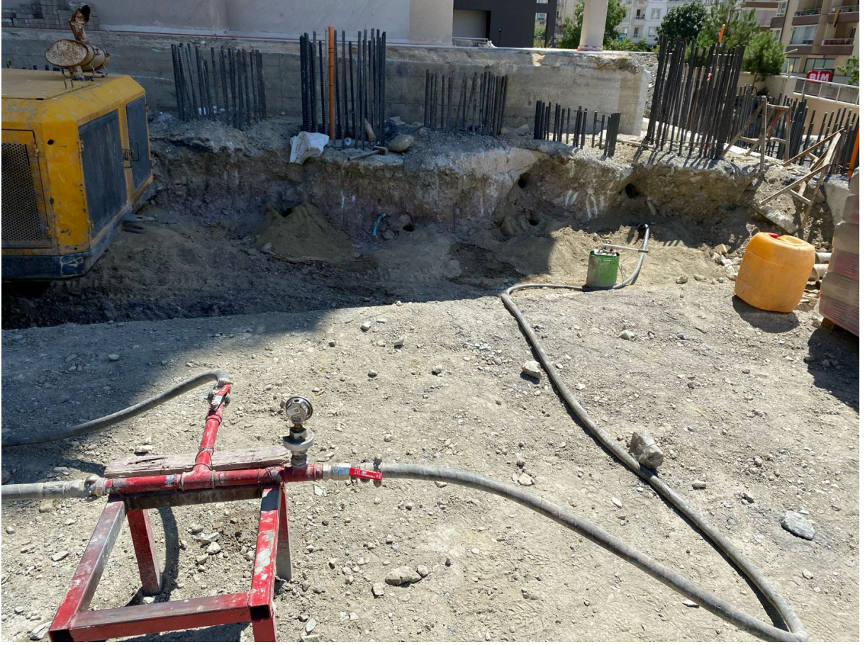
120 cm iksa kazık arası düşük basınçlı permeasyon enjeksiyonu
