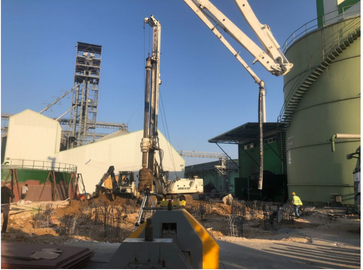
Silo altı kazıklı radye sistemi
