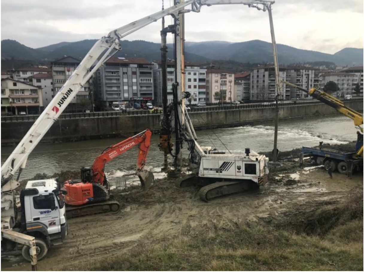
Dere fore kazıklı taşkın önleme
