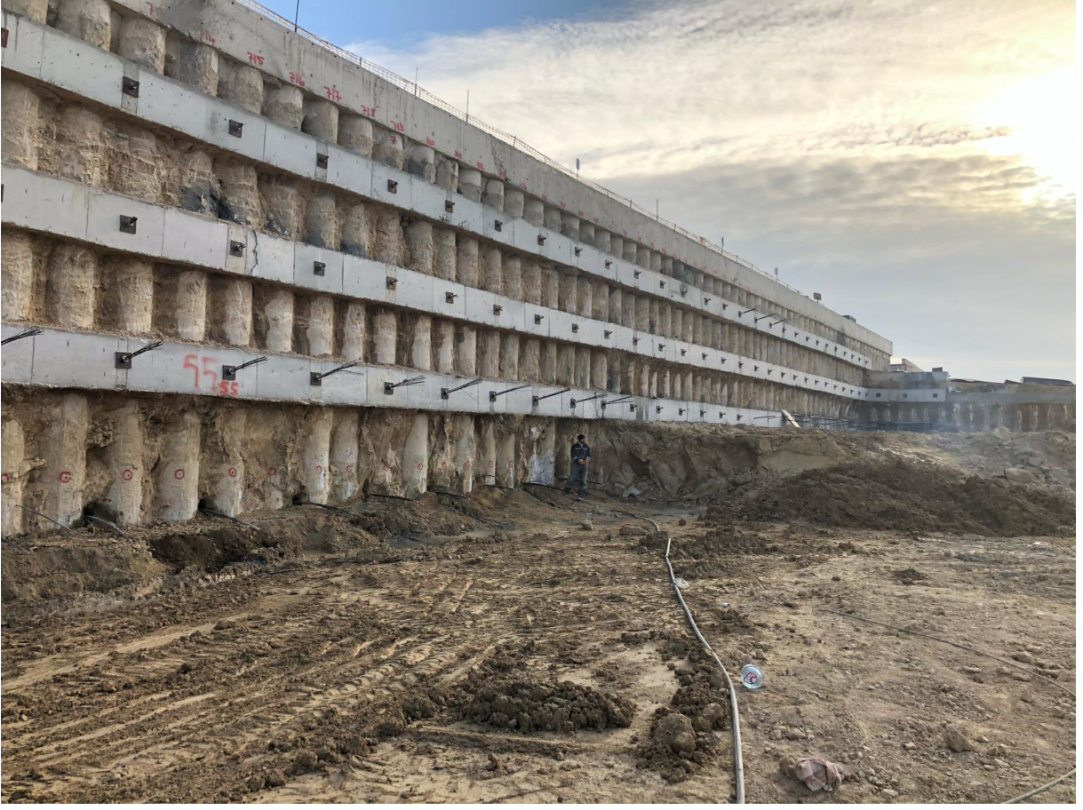
Geçici zemin ankrajlı iksa sistemi
