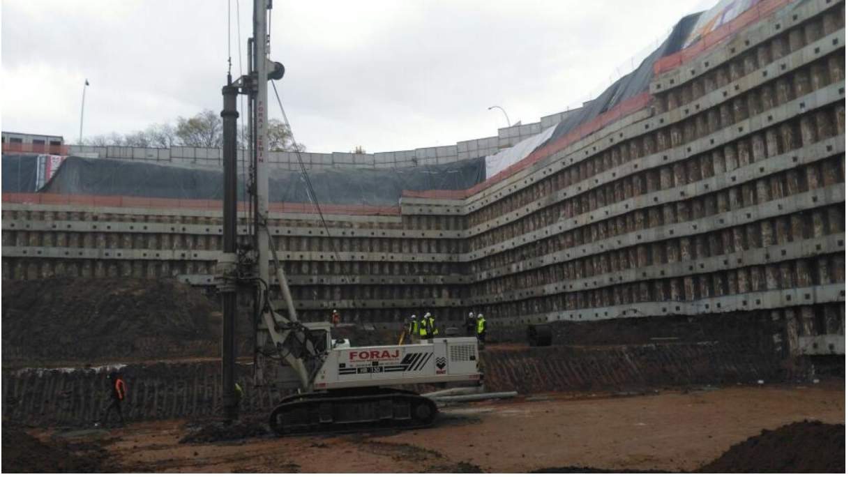
Zemin ankrajlı iksa sistemi
